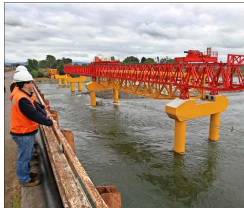
CONSTRUCCIÓN. — Durante la jornada de ayer se comenzaron a instalar las estructuras metálicas por la cual transitarán los trenes de carga.
